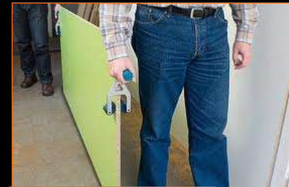
Transporte a mano - sistema para levantar paneles.
