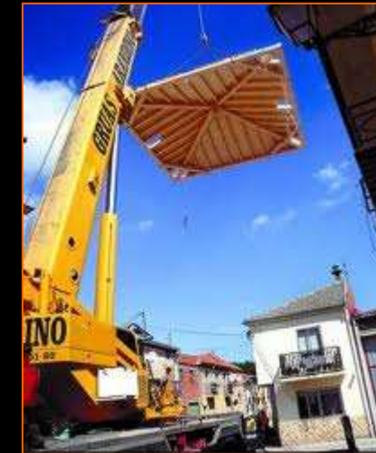
Transporte con camión grúa
