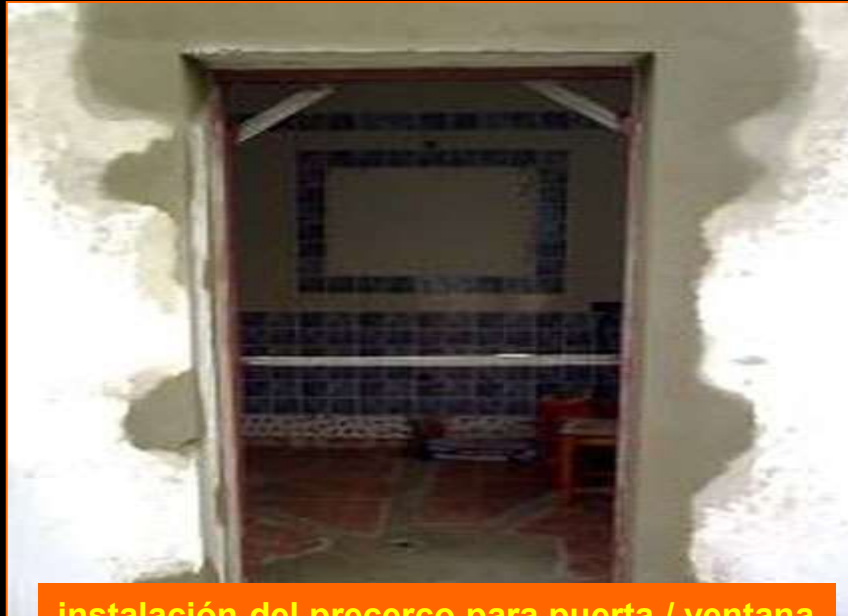
instalación del precerco para puerta / ventana
