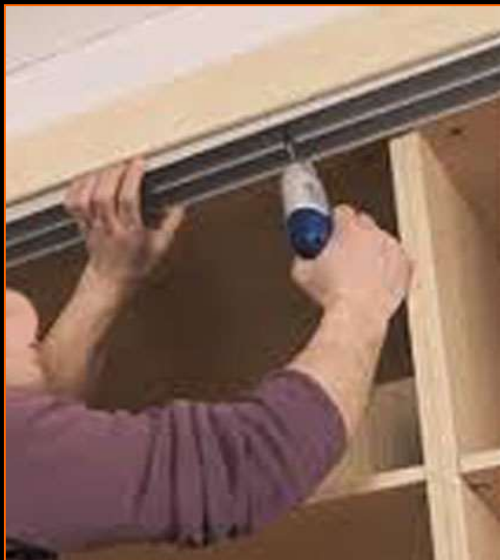
montaje de las guías y sujeción
