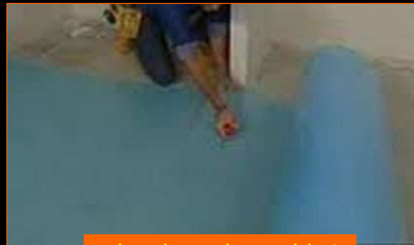
colocar la capa base o aislante
