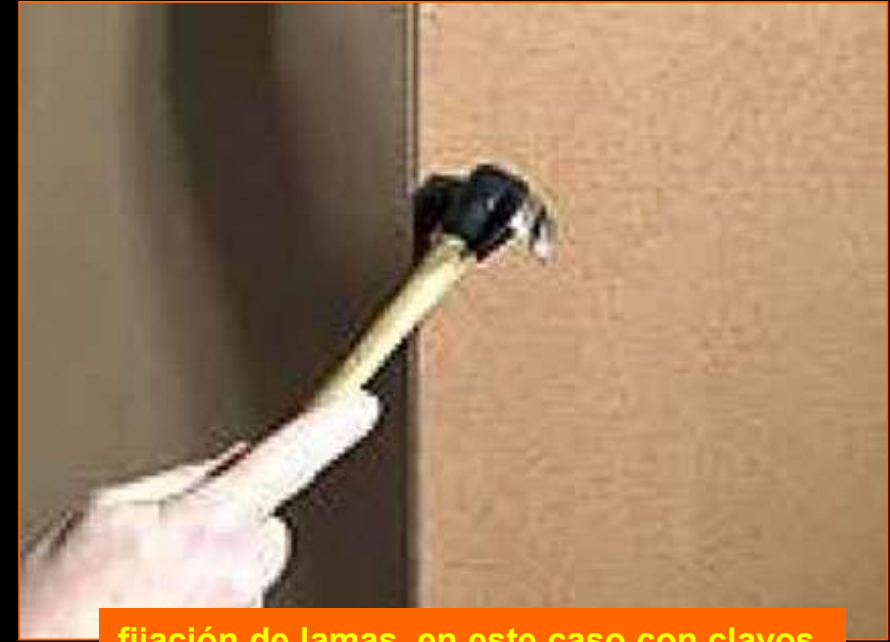
fijación de laminas, en este caso con clavos.
