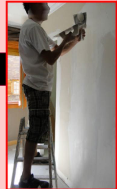
**Caída a distinto nivel** por falta de protección perimetral o usar otros elementos como tablas... para ganar altura.
